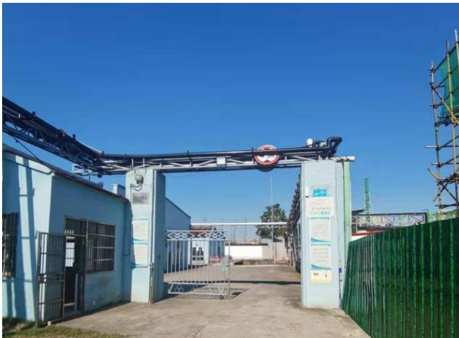
图4.3-1 化学原料仓库区照片
