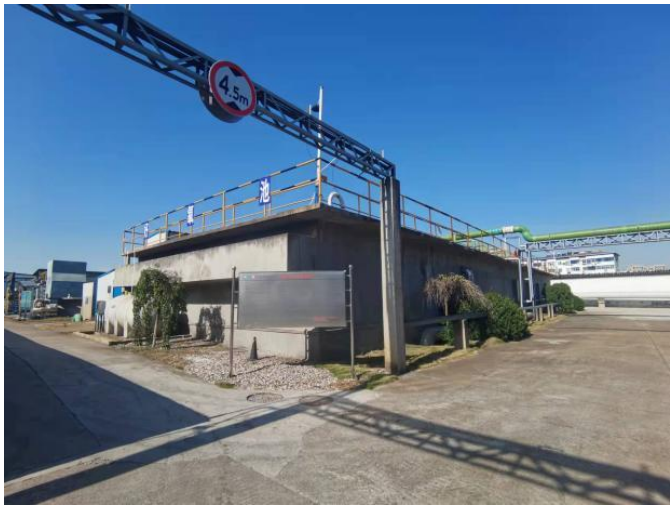
图4.3-2 污水处理站照片
