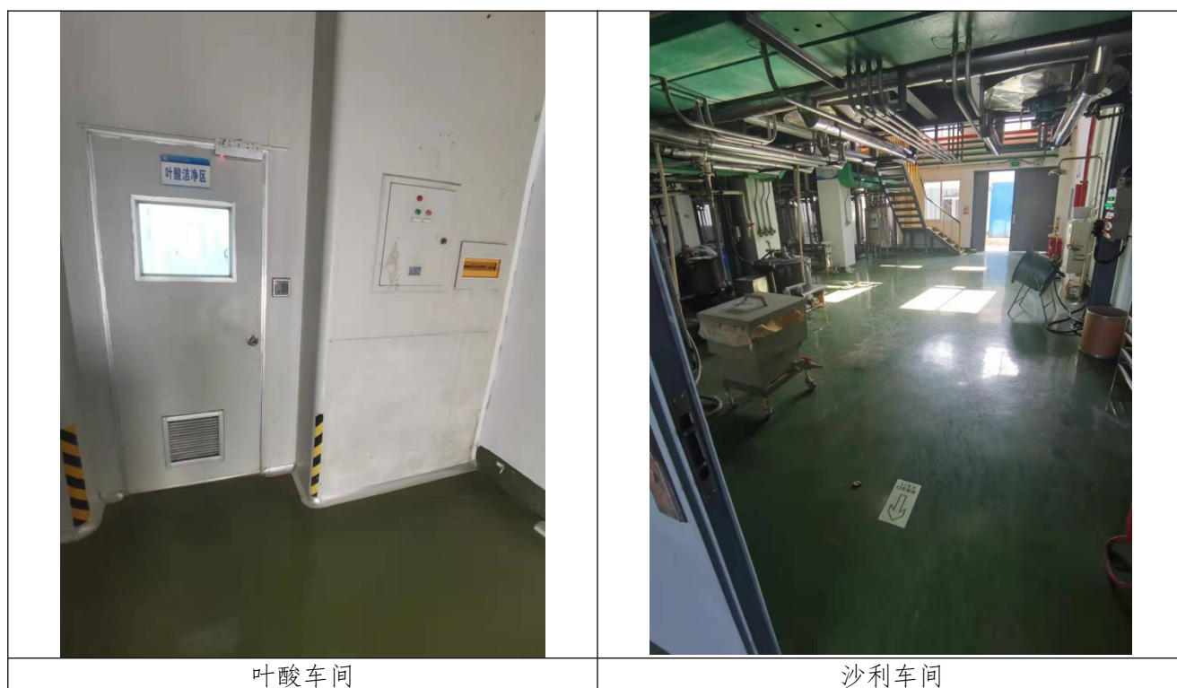
图4.3-7 综合生产区照片
